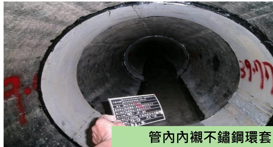
不銹鋼內襯修補完成面示意圖
