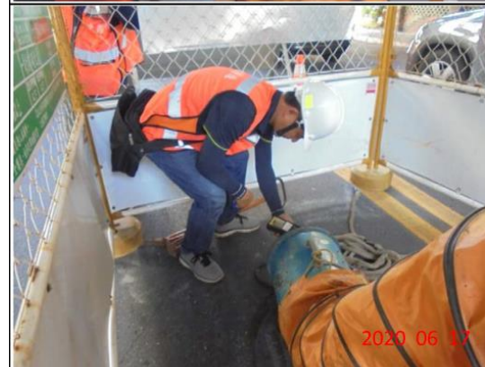
建國北路2段87號 人孔內氣體偵測
