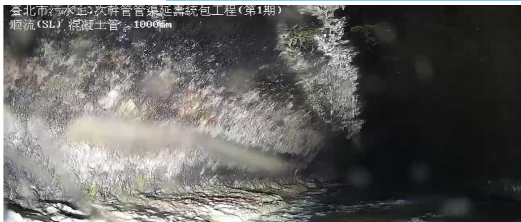
吉林路101號 41470723-414 距離:1.13m 油垢附著 (9~12點鐘方向)
