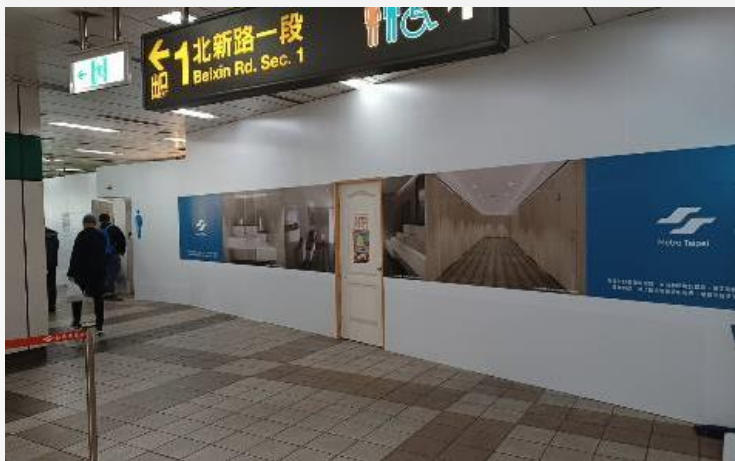
新店區公所站廁所重置工程
