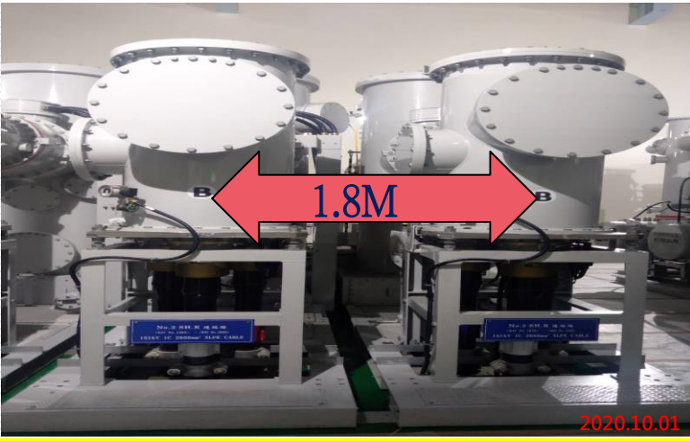
中世代型1.8M 161kV GIS (2000~2004年)
