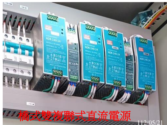
橋式雙複聯式變壓器電源測試
