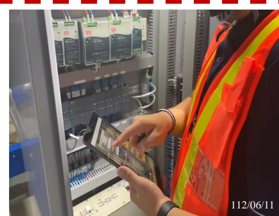
PLC點對點迴路測試(B)
