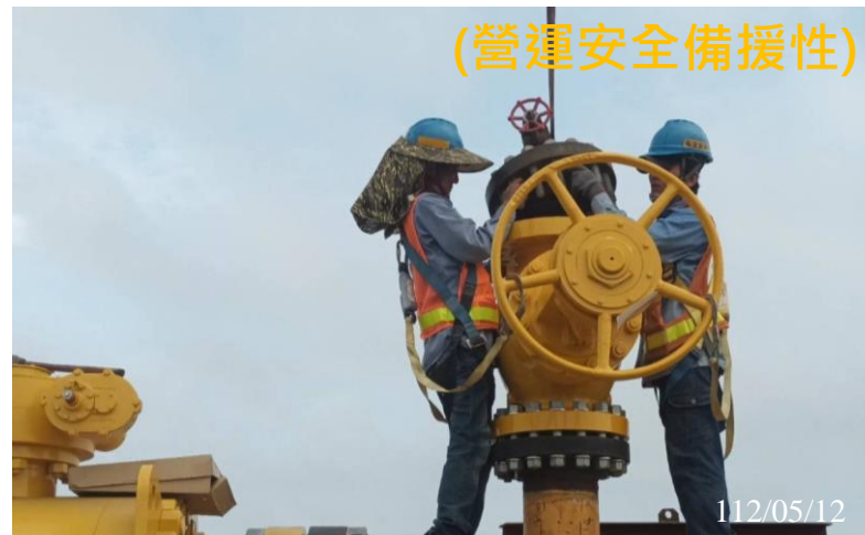
興達端清管站 DN900 手動閥門：7個
