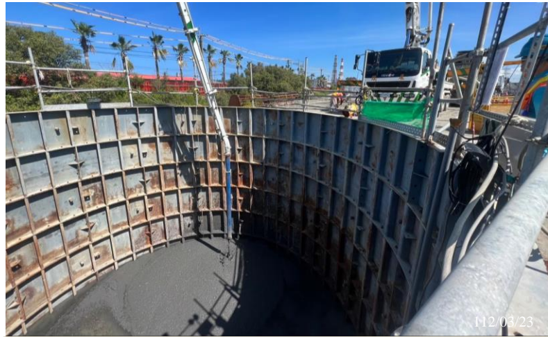
CLSM 完全封填(防災安全1)
