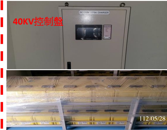
送電前-UPS電池供電試驗
