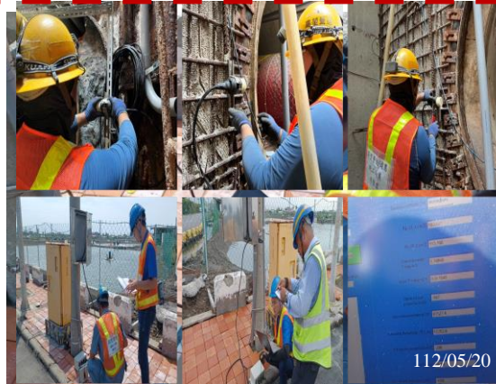
腐蝕監測站數據試驗(2)
