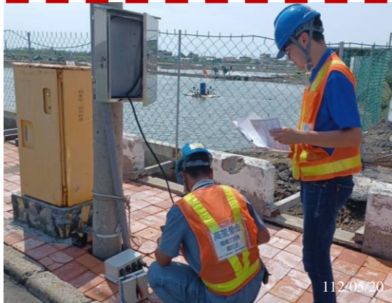
腐蝕監測站數據試驗(1)
