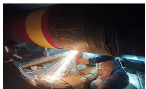
銲道冷卻後研磨 (21:00)
