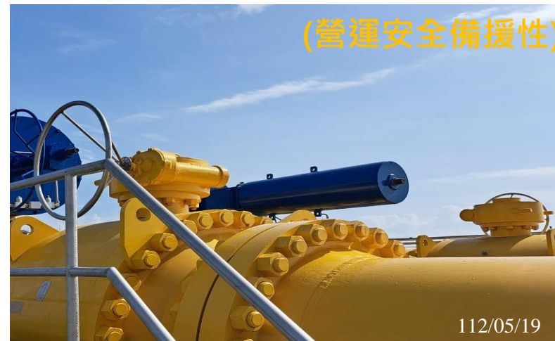
永安端清管站 DN900 手動閥門：6個
