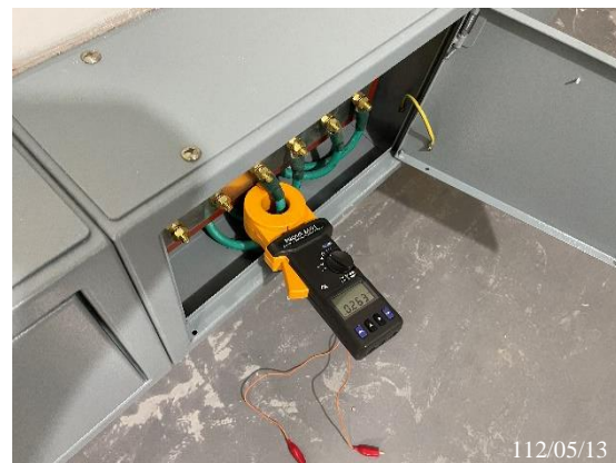
送電前-等電位接地測試
