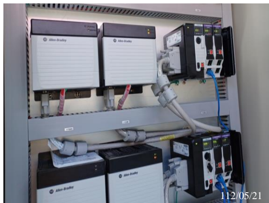
PLC 複聯式(三組)電源供應器測試
