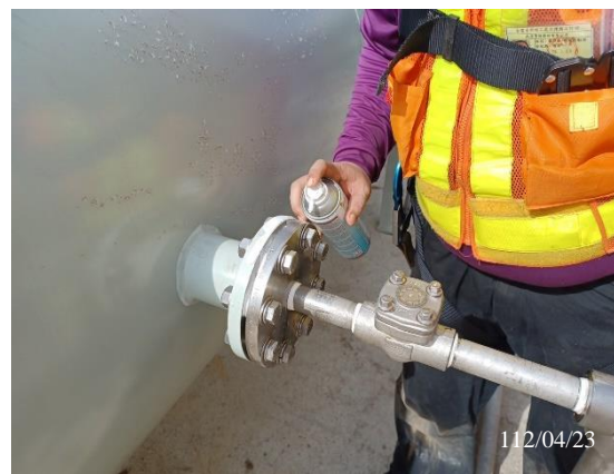
空氣儲槽專用管線洩漏試驗
