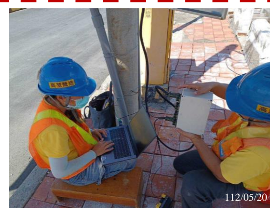
腐蝕監測站數據試驗(3)
