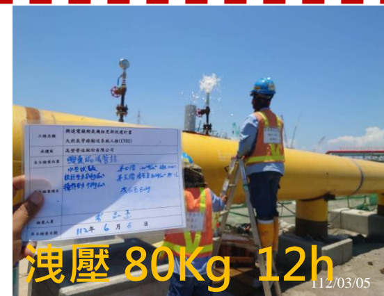
DN900鋼管水壓測試(C)
