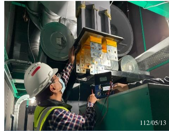
匯流排絕緣測試
