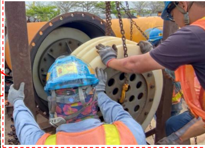
試壓後清管作業
