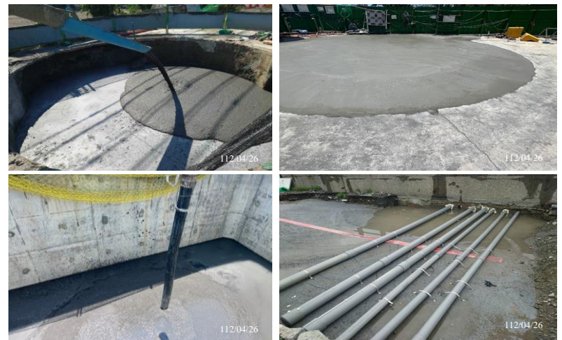
CLSM 完全封填(防災安全3)
