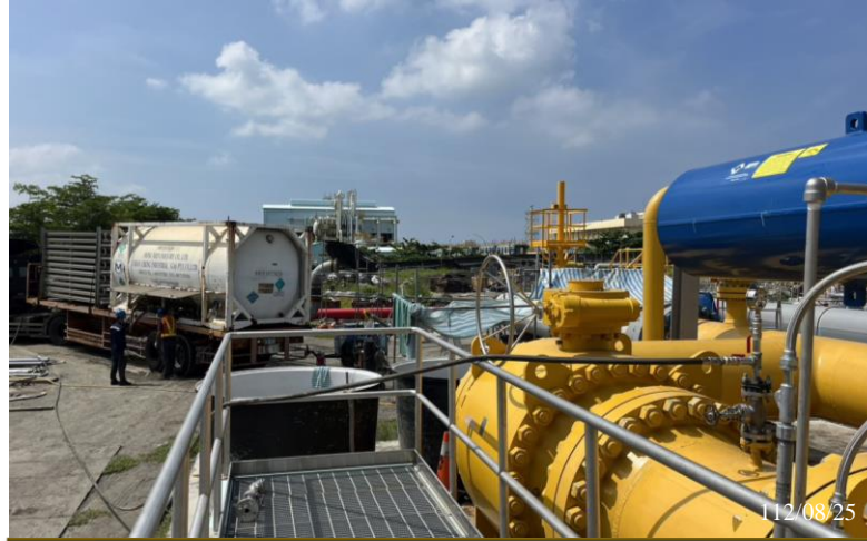
全管線氮氣吹乾(氮封作業2)
