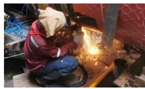
銲道冷卻後研磨 (21:00)
