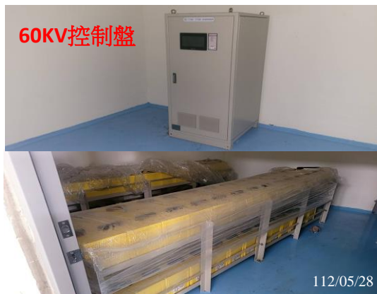
送電前-UPS電池供電試驗
