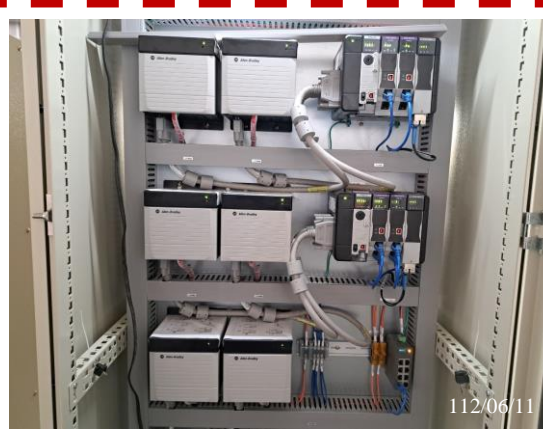
可程式控制器(程式)測試(A)
