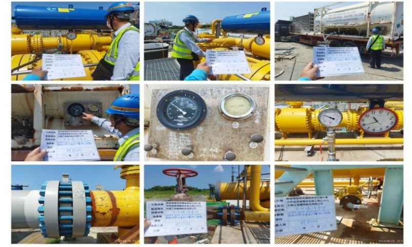
全管線氮氣吹乾(氮封作業3)
