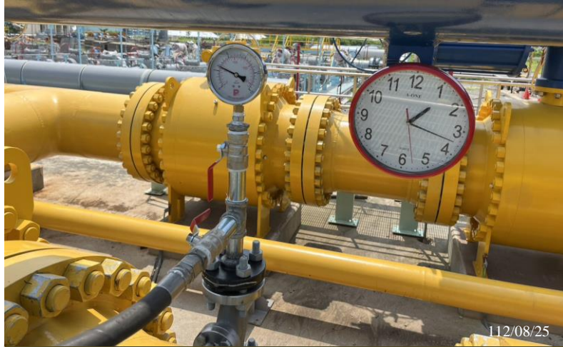
全管線氮氣吹乾(氮封作業1)
