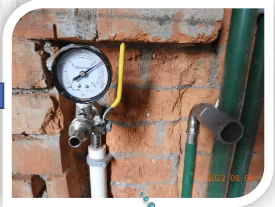
平安舍給水壓力測試
