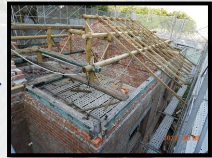
111/06/29日 屋架新舊組立
