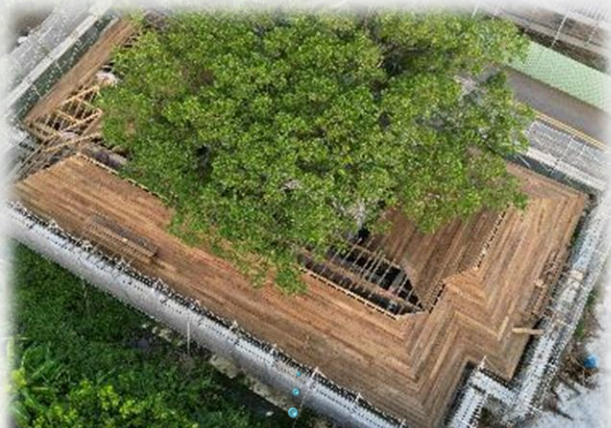
大屯舍屋面野地板
