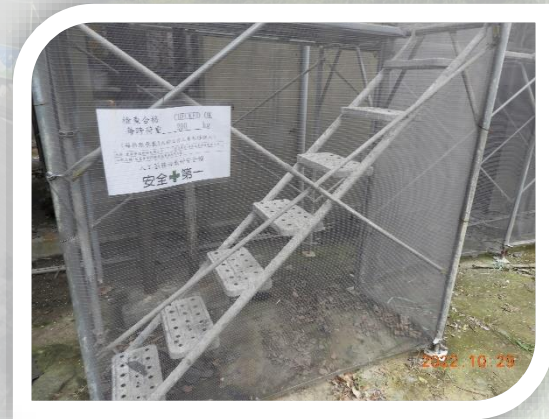
室內施工架滿鋪
