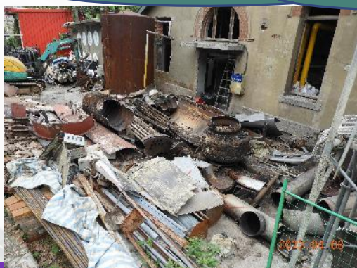
洗衣房後期鍋爐焚化爐協助拆除清理
