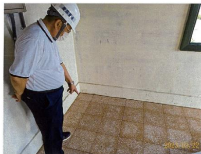
工程名稱: 七星舍等 20 棟修復及再利用工程
