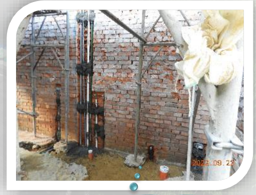
西高雄舍給排水
