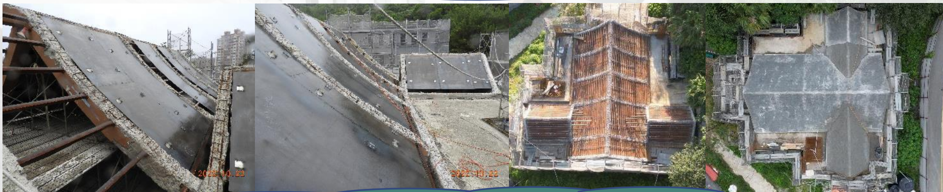
運用鋼板依樑曲度放樣底版灌漿
