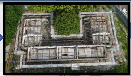
11/04/27日 野地板拆除完成
