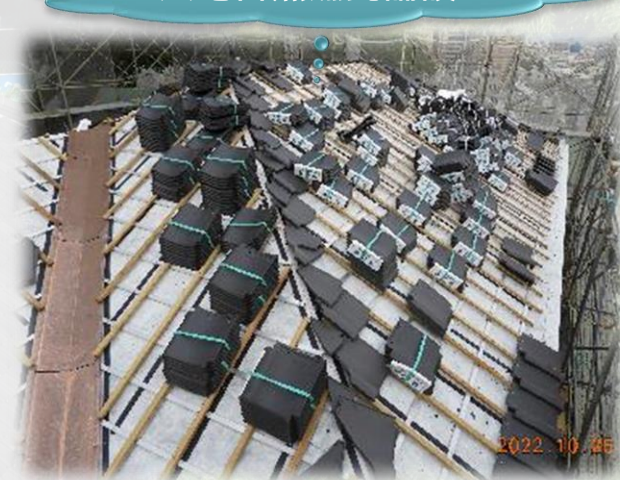
大屯舍黑燻瓦鋪設
