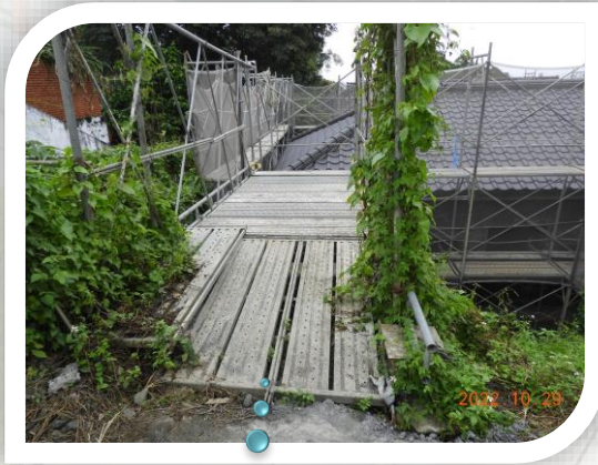
施工平台提高工率及搬運安全
