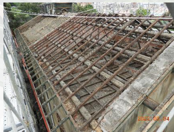
洗衣房屋架母屋垂木保留再利用
