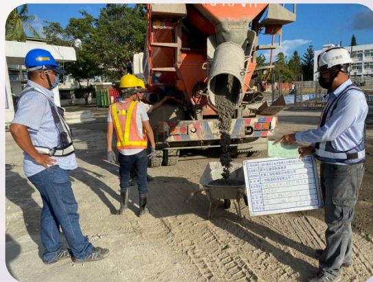
混凝土材料取樣
