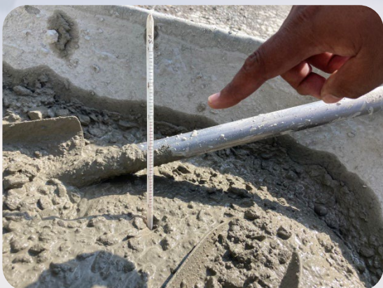
混凝土溫度量測
