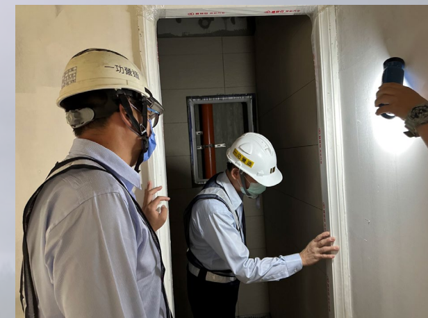
➤ 督察門框安裝執行情形
