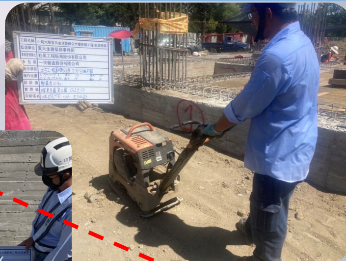
原土回填夯實
