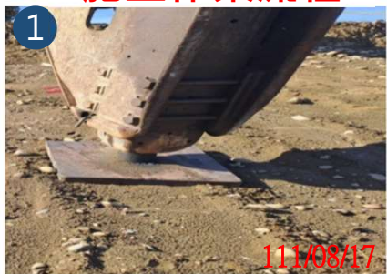
1 修坡整平夯實
