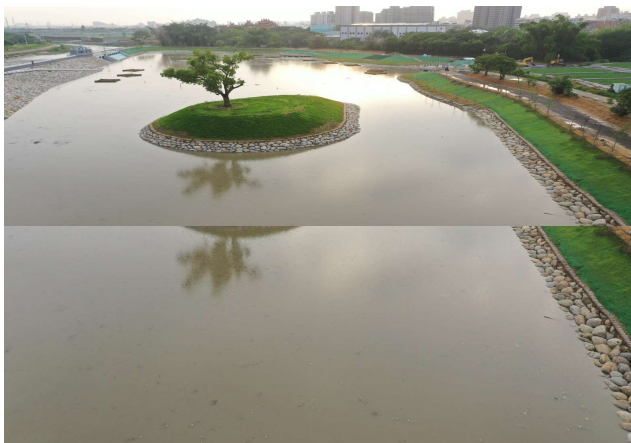
池區主體工程
