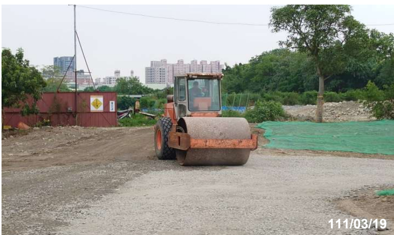
施工便道級配鋪設及夯實
