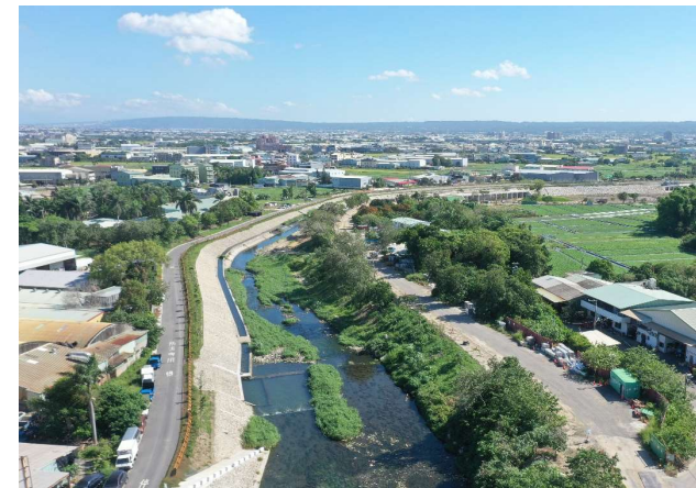
右岸護岸工程
