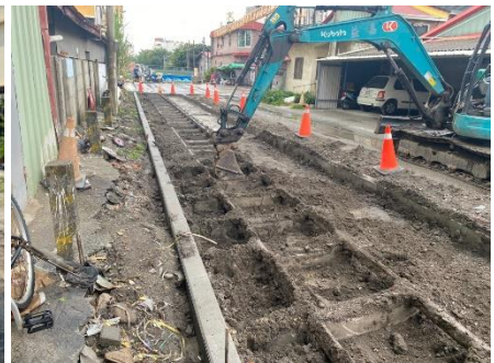
鐵軌開挖狀況
