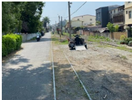
施工前鐵軌狀況
