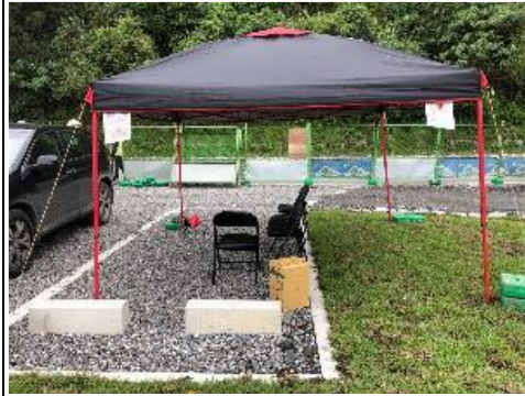
工地安全衛生管理
