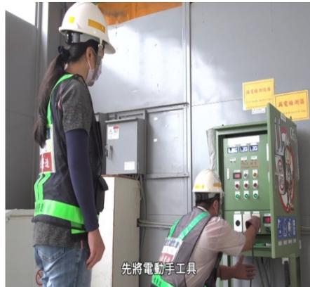
進場手工工具漏電安全檢測
