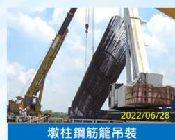
墩柱鋼筋籠吊裝
