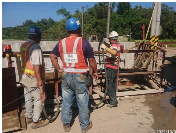
作業主管現場指揮
