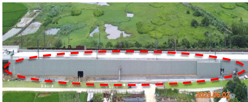
擋土牆油漆噴塗後外觀
