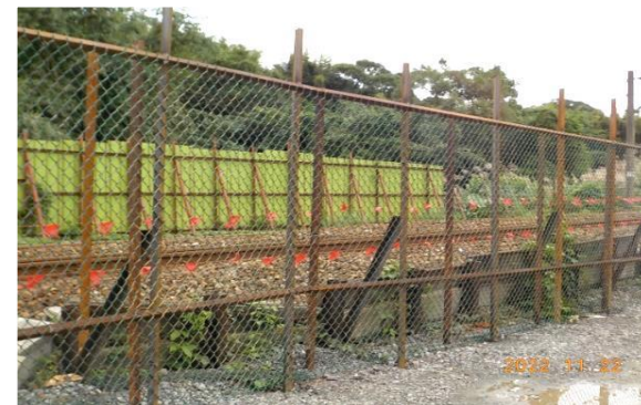
臨軌側防護網設置
