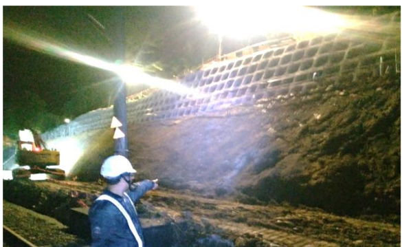
臨軌作業採夜間施工
