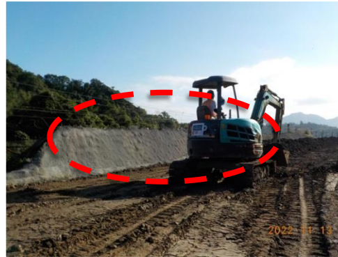
保留土堤噴凝土保護
