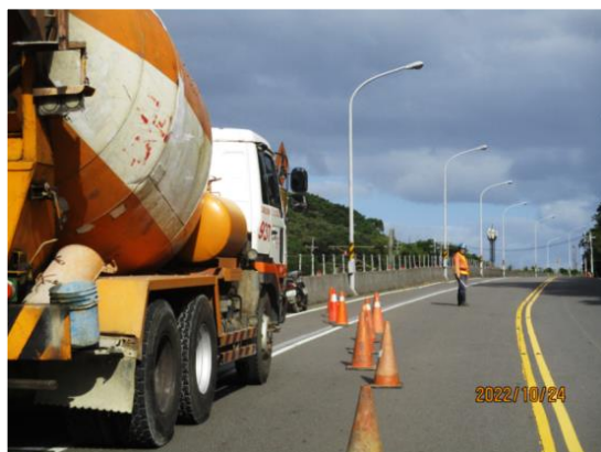
工區大門前道路指揮
