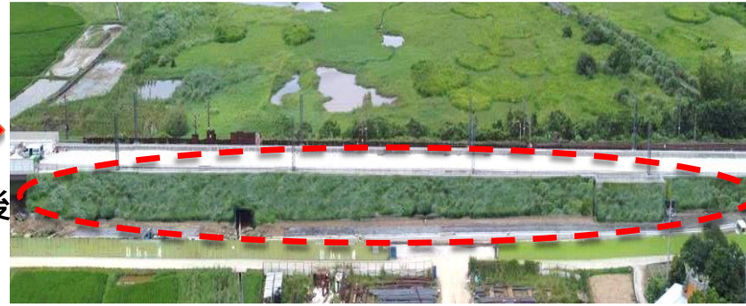
擋土牆掛網植生完成示意
