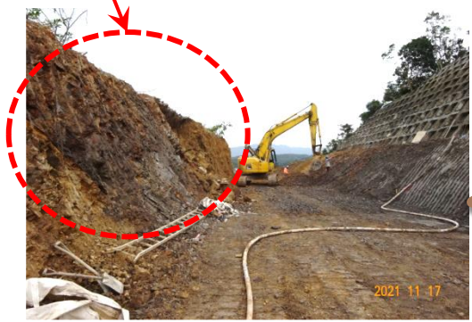
保留土堤作為屏障-挖掘邊坡內土堤及自由型格梁施作
