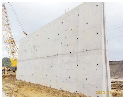
擋土牆完工外觀
