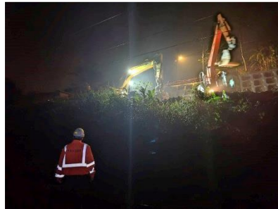
夜間挖掘土堤
