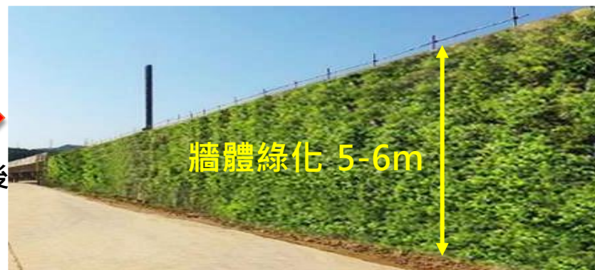
擋土牆掛網植生完成示意
