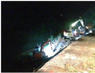
夜間挖掘土堤
