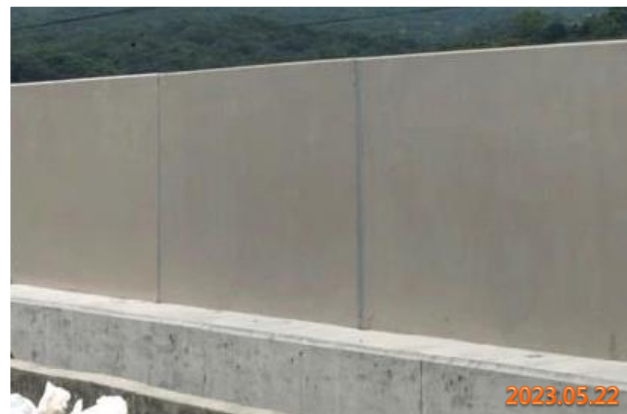
抗污耐候性佳之油性平光水泥漆噴塗
