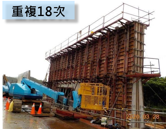
擋土牆鐵模模貝化
