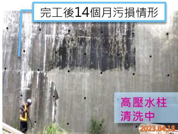
擋土牆完工14個月後外觀
