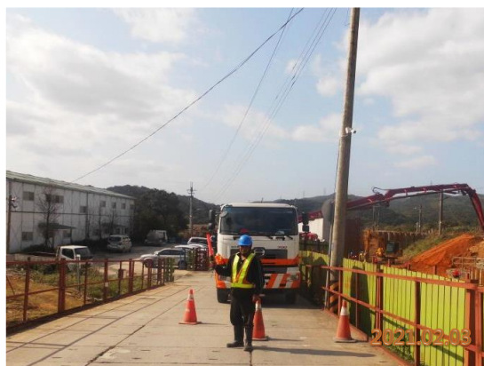
施工便橋交通指揮
