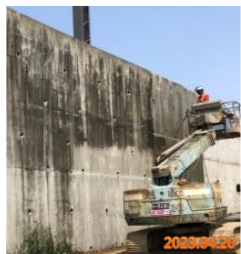
新增掛網前 高壓水柱清洗
