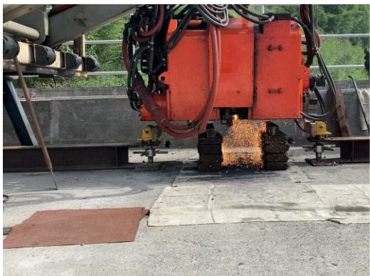
閃火對壓接焊接(全電腦控制)
