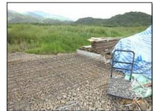
工區臨時便道及材料堆置加工場利用本局回收廢渣石料填築利用降低砂石開採之能源消耗。
