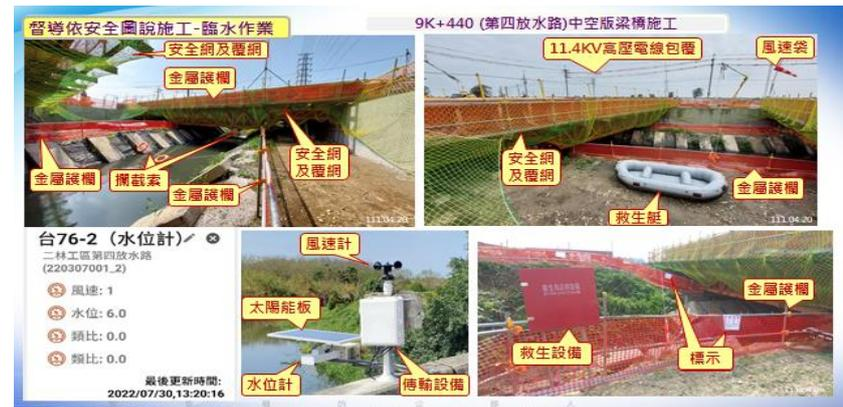
十九、工區內有台電高壓線，超高壓線橫越，設置區隔示警，張貼警告標語，絕緣包覆，運用科技電子圍籬及UWB感應器，監視人員等確實辦理感電風險相關防護措施。
