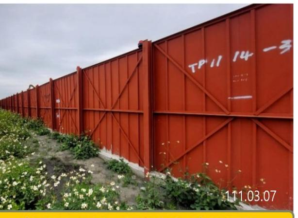
工區出入口部分圍籬採H型鋼架加強穩固性
