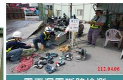
電工漏電斷路檢測
